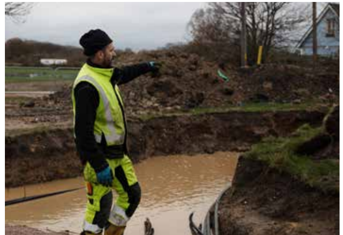
Det har regnat i höst och diken där elledningarna ska grävas ner blir vattenfyllda. Vi blickar dock framåt och vet var vi ska gräva.
